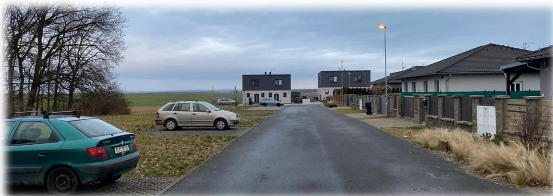
Obr.: Veřejný prostor P3/22 – souběžný pás mezi lesem a realizovanou obytnou zástavbou
