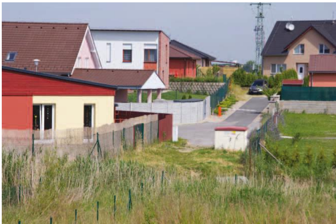
Výstavba ulice Nad potokem - pohled směrem od lesíku.
