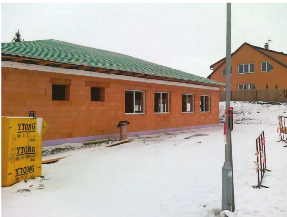
Výstavba mateřské školy v ulici Nad hřištěm.
