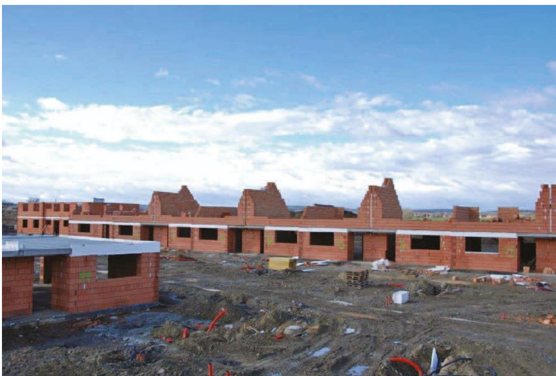
Výstavba řadových domů v ulici nad Hřištěm.
