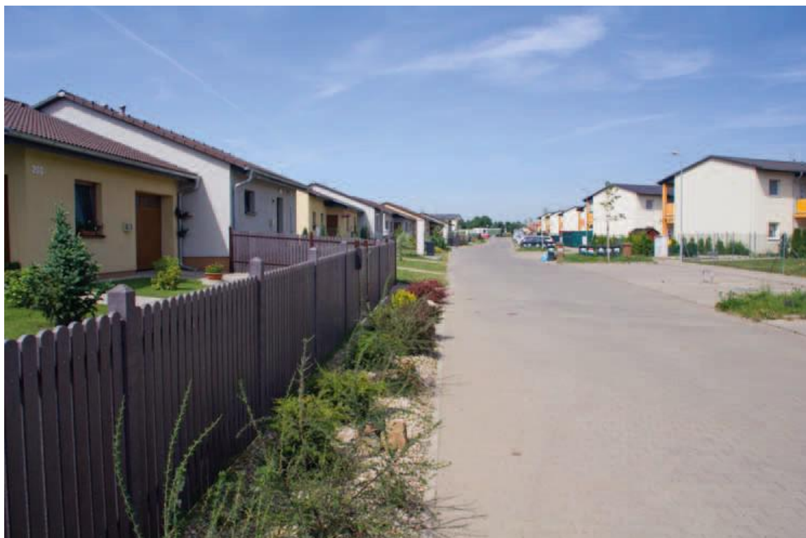
Zástavba v lokalitě Nad obcí.
