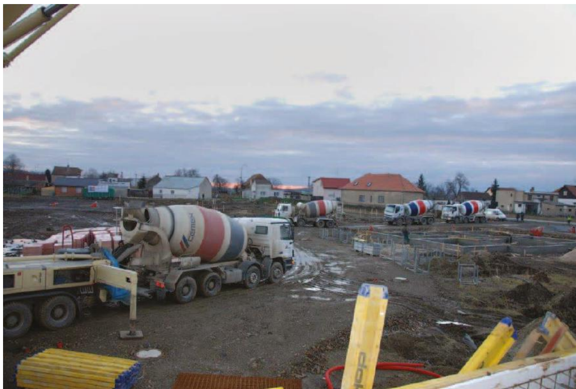
Výstavba bytových domů v ulici Nad hřištěm.
